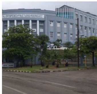
Hospital. Foto: ICLEP
