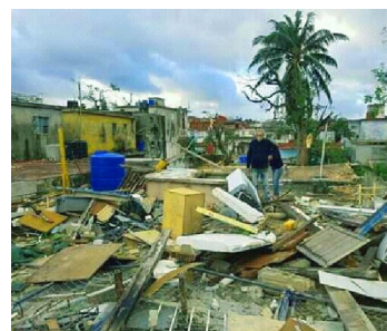
Derrumbe, Luyanó. Foto: ICLEP
