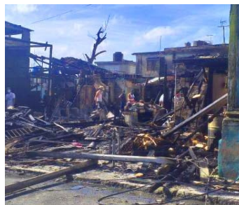
Lugar del incendio. Foto: ICLEP
