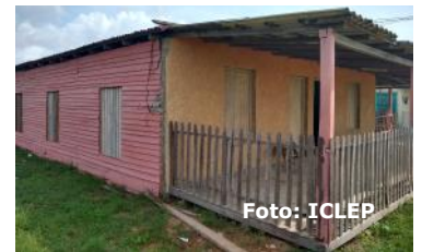
Casa con el metro contador retirado lista para demoler
