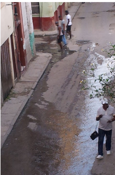
Imagen de las aguas albañales corriendo por las calles
