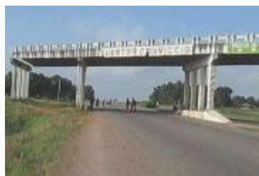
Puente de Taco Taco
