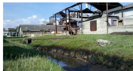
Zanja por donde vierten los residuos
