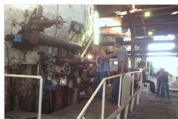
Casa de Calderas
