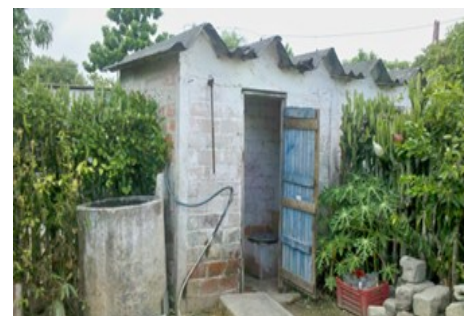
Baños en la comunidad 26 de Julio
