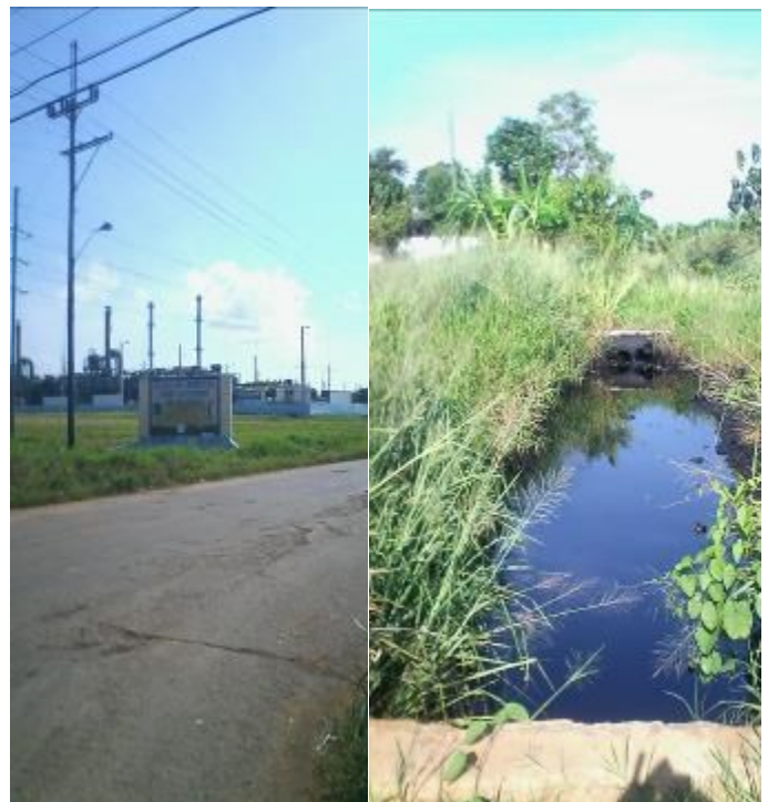
Grupo electrógeno del municipio de Güines perteneciente a la "Revolución energética" y contaminación de las aguas potables del lugar. Fotos: el autor
